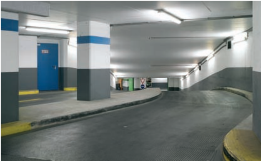
Hier ist Parkplatzsuche kein Glücksspiel – einfach hineinfahren und den Wagen abstellen
