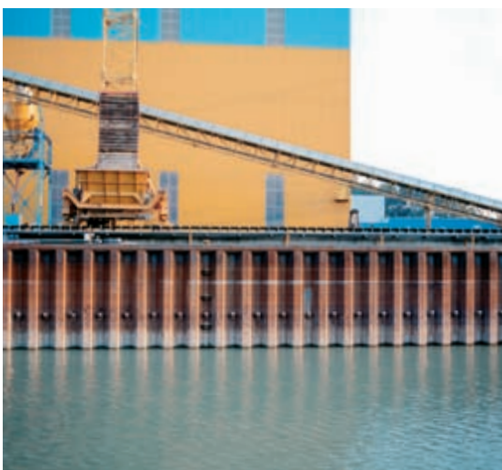
Umschlagplatz mit der neuen Spundwand im Hafen Albern
