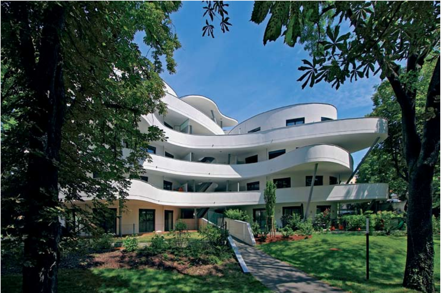
Das Wohnhaus Cumberlandstraße mit seinen geschwungenen Formen und Terrassen liegt mitten in einem parkähnlichen Garten
