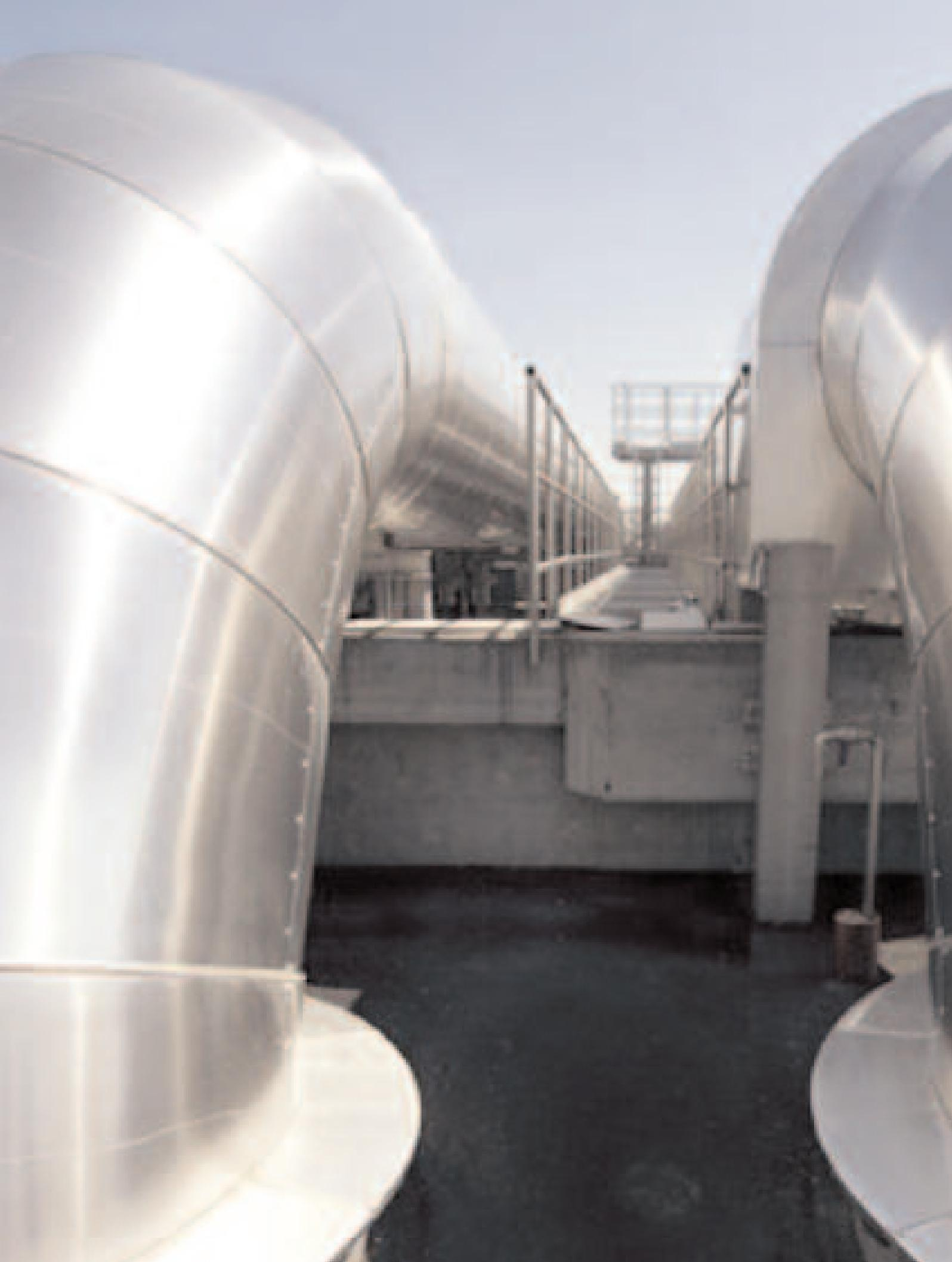
Highways der besonderen Art: In diesen Rohrleitungen wird die Luft für die Mikroorganismen transportiert (bis zu 180.000 Kubikmeter/h)
