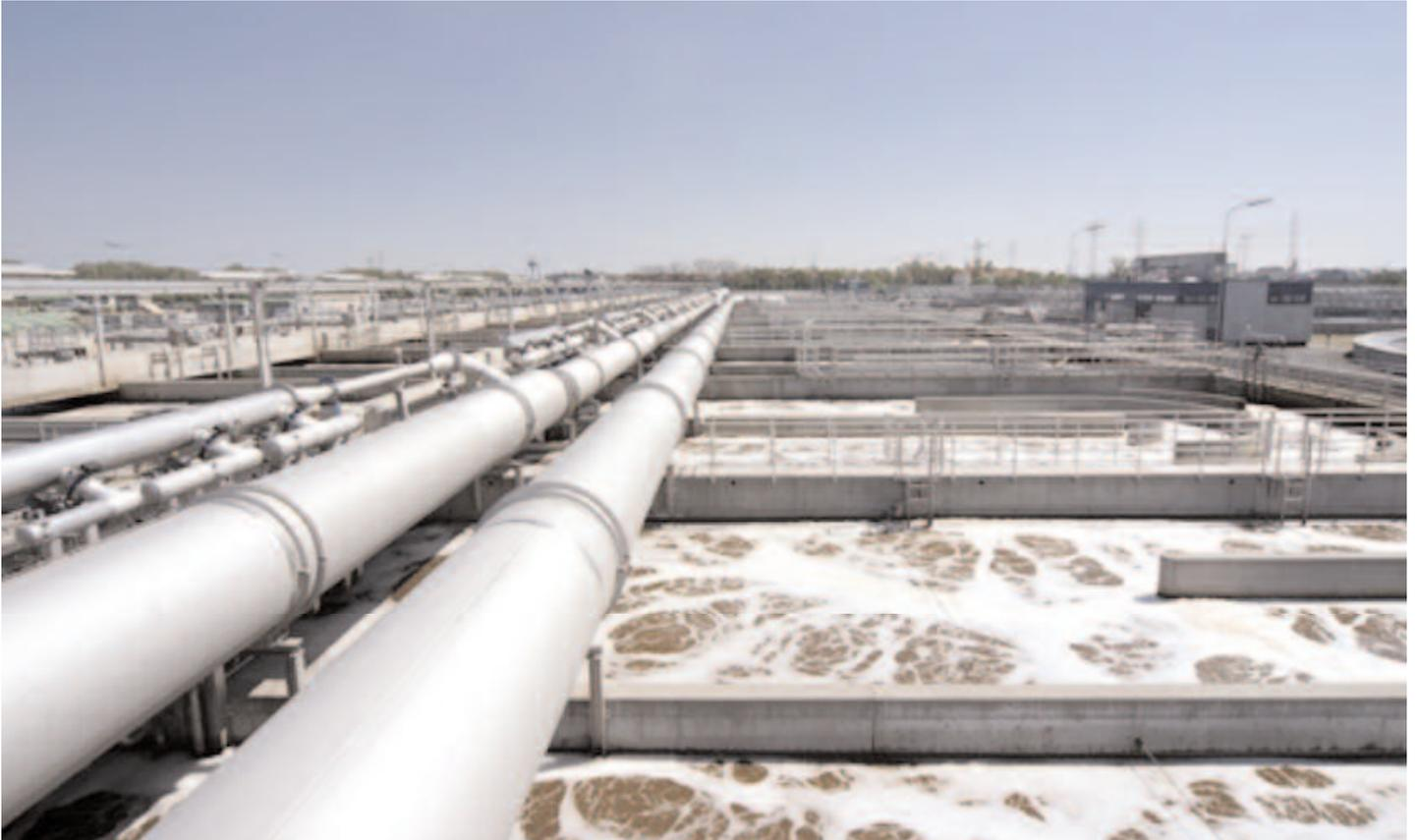
Mikroorganismen „at work“. In den Belebungsbecken der zweiten Stufe steht ein bedeutender Schritt in der Abwasserreinigung an: die Stickstoffentfernung
